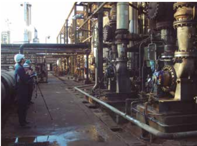
Trabajos de ingeniería acústica en Argelia. Acoustic engineering project in Algeria.
